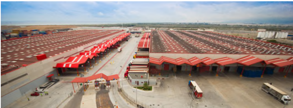
Foto: instal·lacions gestionades per Alfil Logistics a la ZAL
